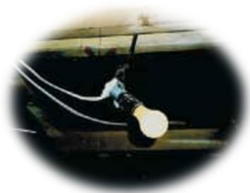
El peso del dispositivo puede dañar el cable. Los cables expuestos pueden provocar un arco eléctrico que podría inflamar los combustibles cercanos.
