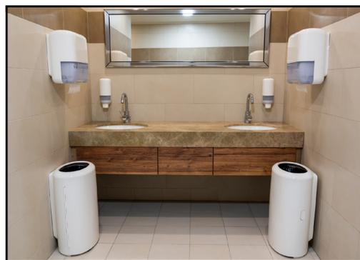
Outre la disposition des poubelles qui limite l'accès aux lavabos, le dégagement sous ce comptoir n'est pas suffisant pour permettre à une personne se déplaçant en fauteuil roulant d'utiliser le lavabo.
